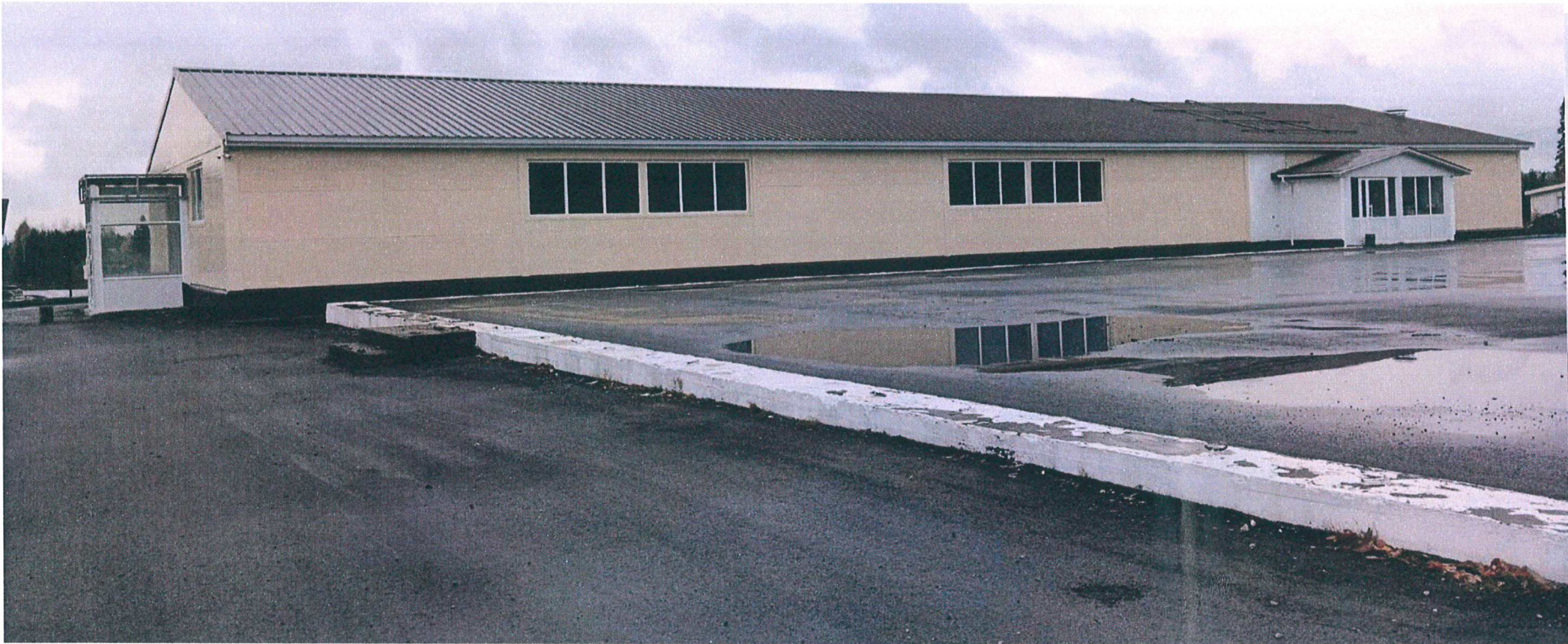
Существующее состояние главного фасада (фотофиксация)
