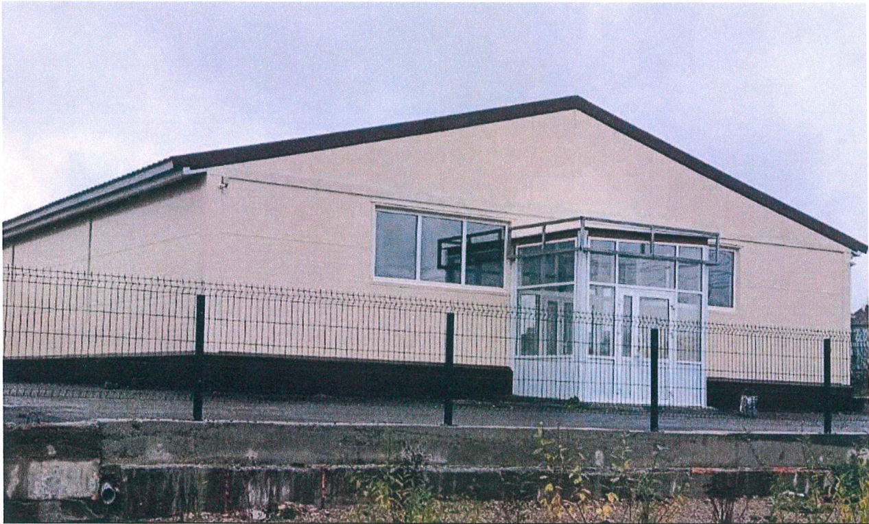
Существующее состояние бокового фасада (фотофиксация)
